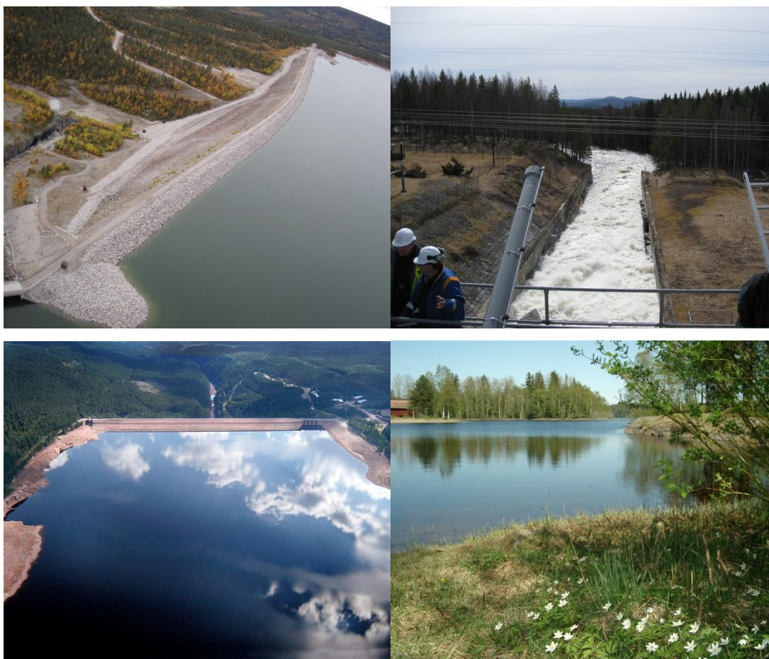
Figur 2.11. Flygbild över Seitevare-dammen med Tjaktjajaure magasinet nästan uppe vid dämningräns (överst till vänster, copyright Vattenfall, fotograf Jennie Nilede), utskov i Torpshammar med pågående spill (överst till höger, copyright Vattenfall, fotograf Erik Nordström), flygbild över Trängslettdammen (nederst till vänster, copyright Fortum, fotograf Stefan Sjödin), samt Gruvsjön (nederst till höger, copyright Boliden, fotograf Jenny Gotthardsson).
