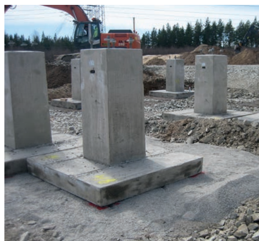
Montage av prefabricerade fundament.
