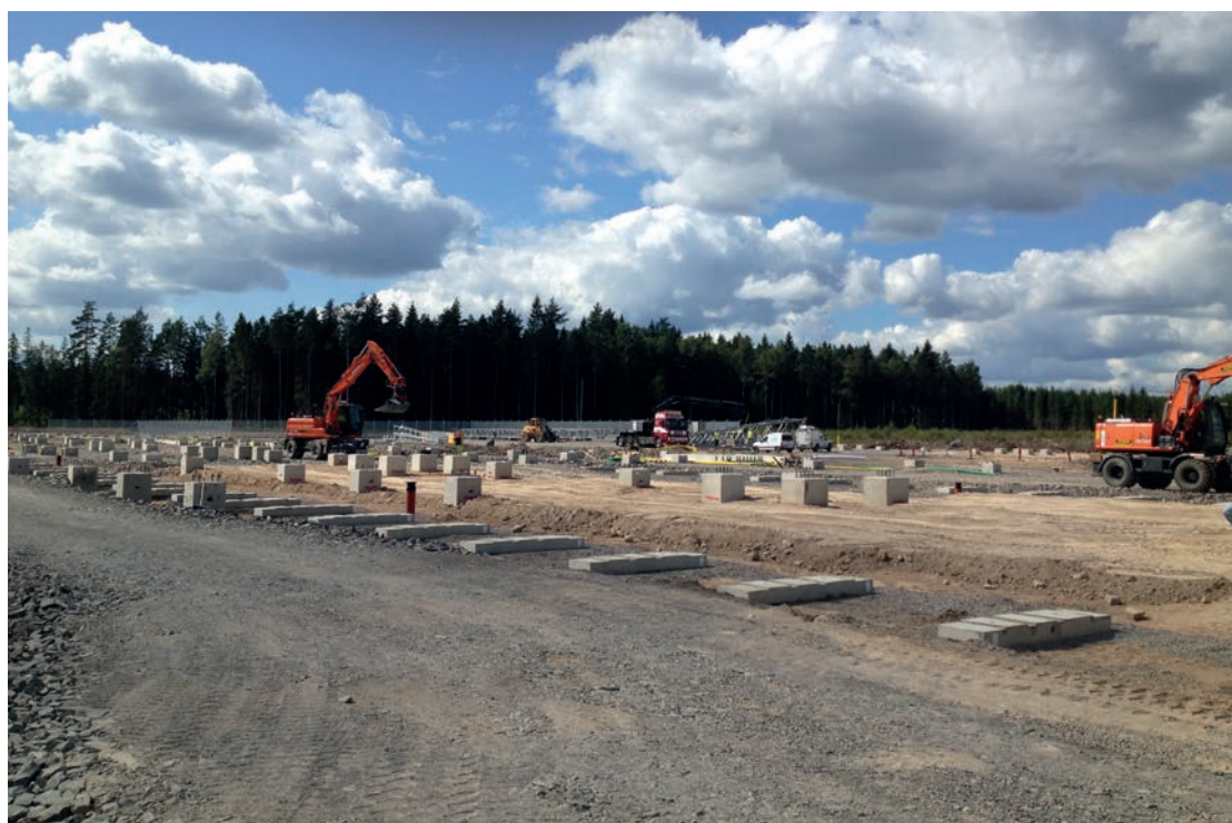
Ställverket med utplacerade fundament. Fotot visar även hur ett staket börjat byggas runt anläggningen. Fotot är taget från manöverhuset och rakt västerut.
