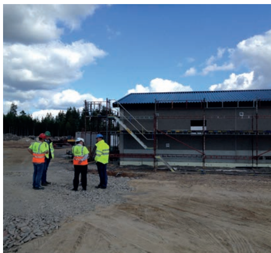
Det nybyggda manöverhuset.
