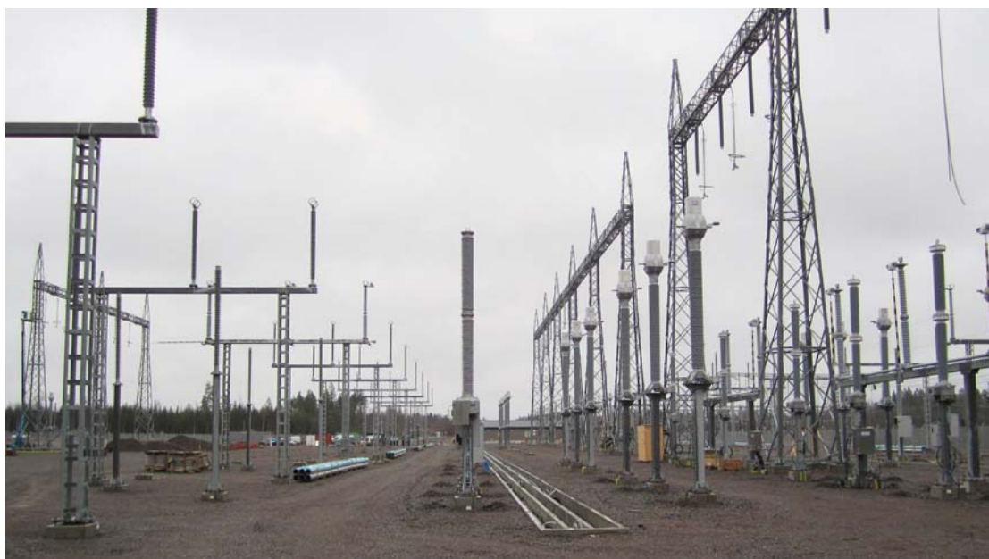
Det nya växelströmsställverket är i det närmaste färdigmonterat. Här syns den norra delen, där den intilliggande omriktarstationen ska ansluta när den är färdigbyggd.
