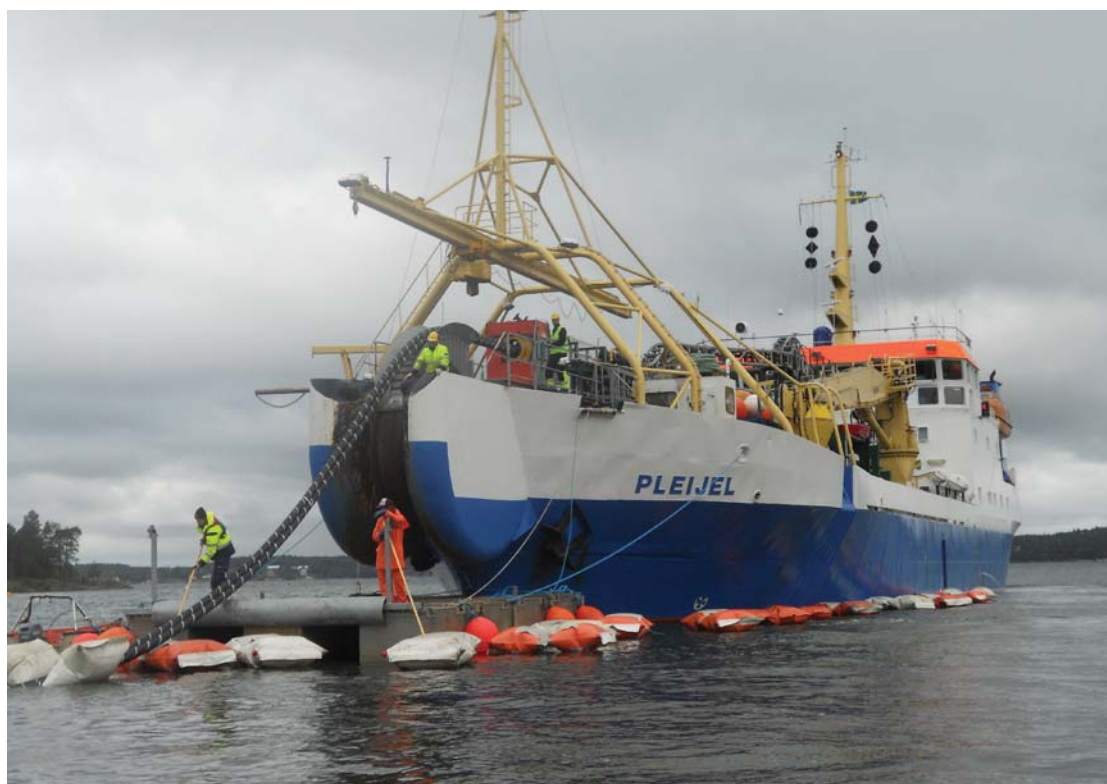
Sjökabeln läggs ned med hjälp av ett särskilt kabelförleggningsfartyg. Nära land, där det är grunt, används flytkuddar för att transportera kabeln i vattnet. Fotot är taget vid nedläggning av sjökabel i ett annat av Svenska kraftnäts projekt.
