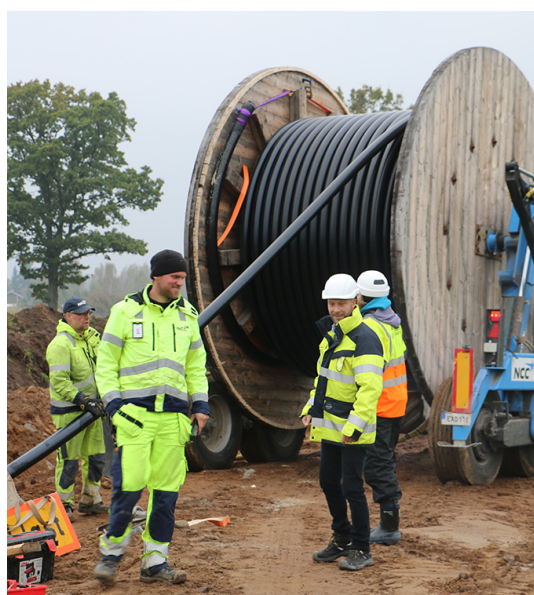
Kabeltrummorna väger ca 20 ton och rymmer ca 1000 m kabel.
