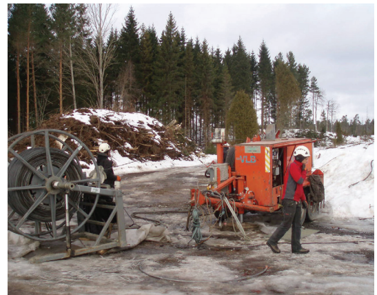
Faslinorna rullas upp på linhållare efter nedmontering från stolparna. Foto: Tore Gunnarsson
