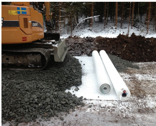
Vägbygge vid Bona, norr om Motala. På grund av markens dåliga bärförmåga krävs grundläggning med både markduk och geonät som sedan täcks med bergkross från närliggande täkt. Foto: Anders Bard
